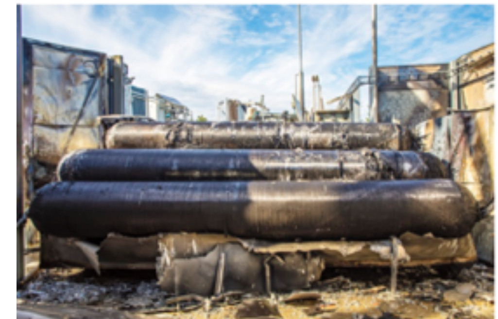
Sandvika, Norvège, 2019 Explosion d'une station d'hydrogène
